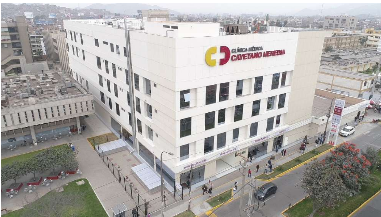
Vista de la Clínica Médica Cayetano Heredia mostrando la nueva torre hospitalaria, diciembre 2020.
